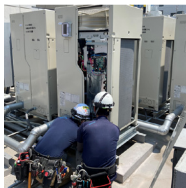
EMS制御機の取り付けの様子
